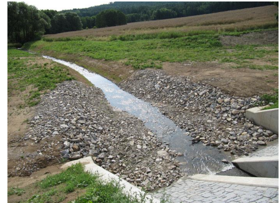
Oprava poldru Cehnice
